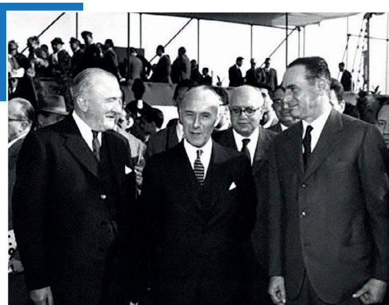
Enrico Mattei e il Ministro Inglese Lord Percy Herbert Mills. Posa prima pietra Centrale Termo Nucleare di Latina, 28 novembre 1958 (archivio storico Eni)
